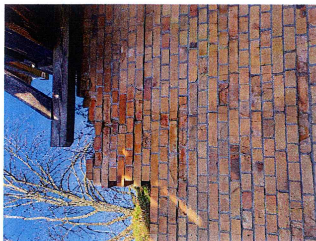
6. Widok spękanej ściany murowanej
