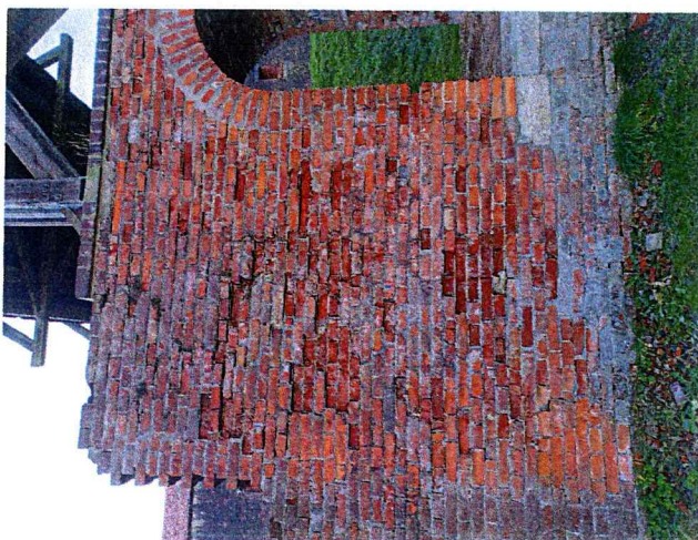
7. Widok ubytków w licu ściany murowanej
