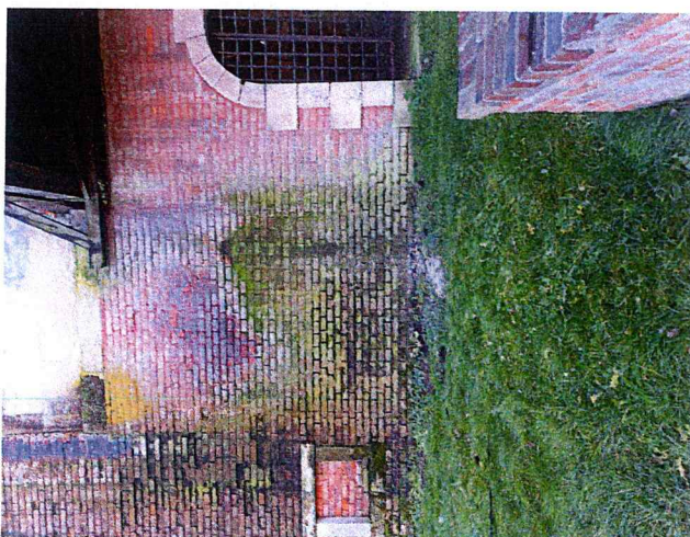
8. Widok ubytków w licu ściany murowanej bramy oraz efekty zalewania wodami opadowymi
