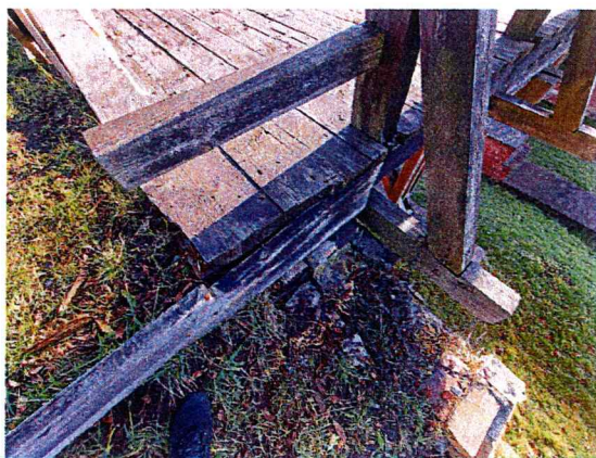
5. Rozszczelnienie połączenia słupa i zastrzału z belką
